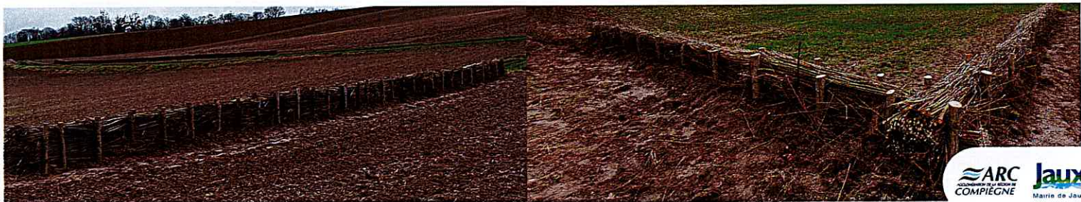
Commune de Jaux : fascine perpendiculaire à un axe de ruissellement / fascine en point bas d'une parcelle
